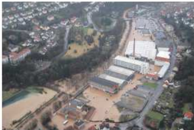
Die Hochwasserrisiken für das eigene Unternehmen lassen sich im Internet abufen.
