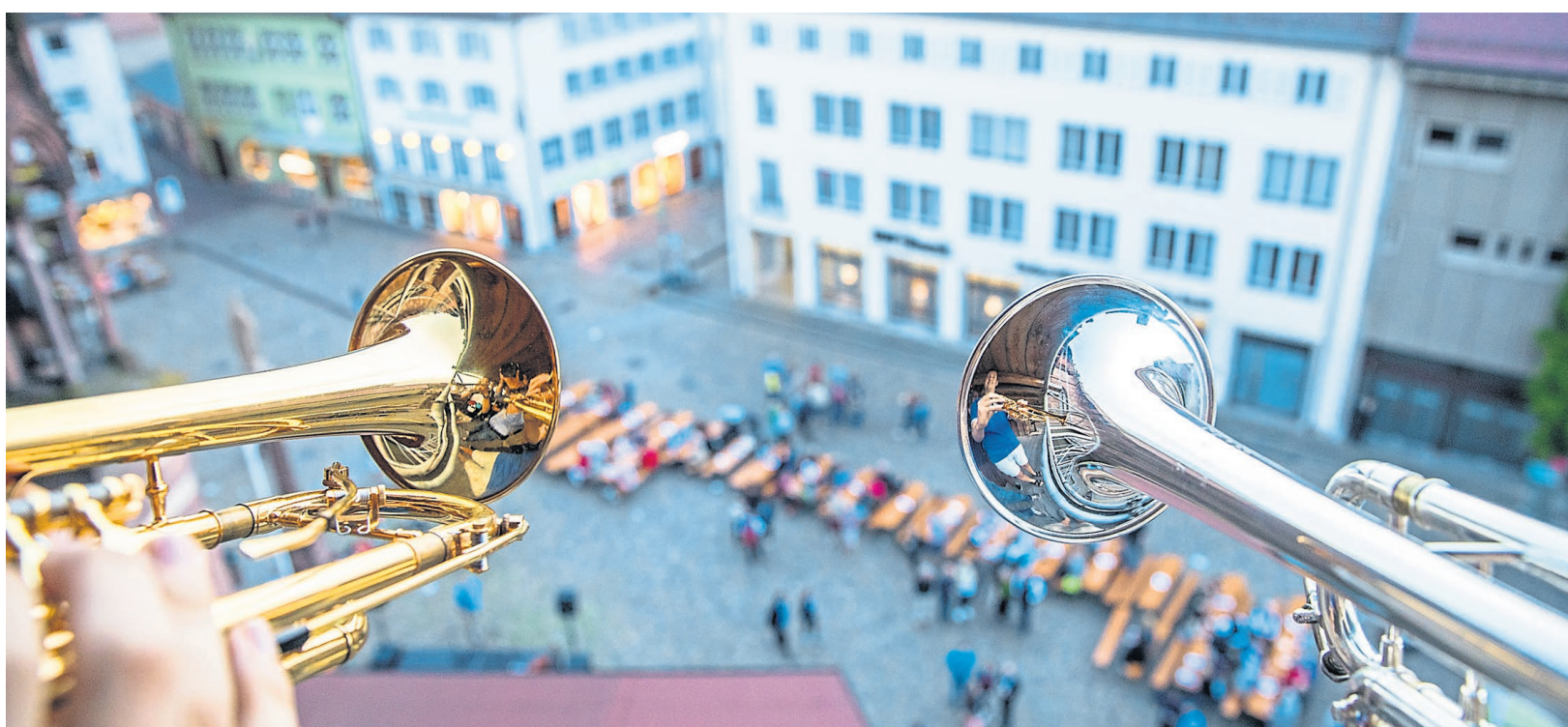
Die Trompetenklänge vom Münster verkündeten die frohe Botschaft: Die Sanierungsarbeiten am Münstersturmhelm sind beendet.
