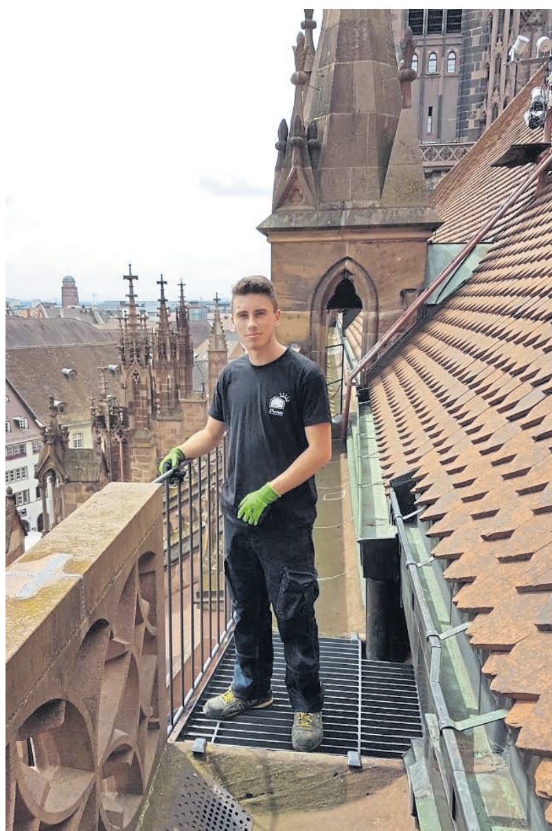
Arbeitseinsatz an Freiburgs Wahrzeichen: Maxime Dupré montierte das von ihm gefertigte Haltegitter am Freiburger Münster in luftiger Höhe. Foto: privat
