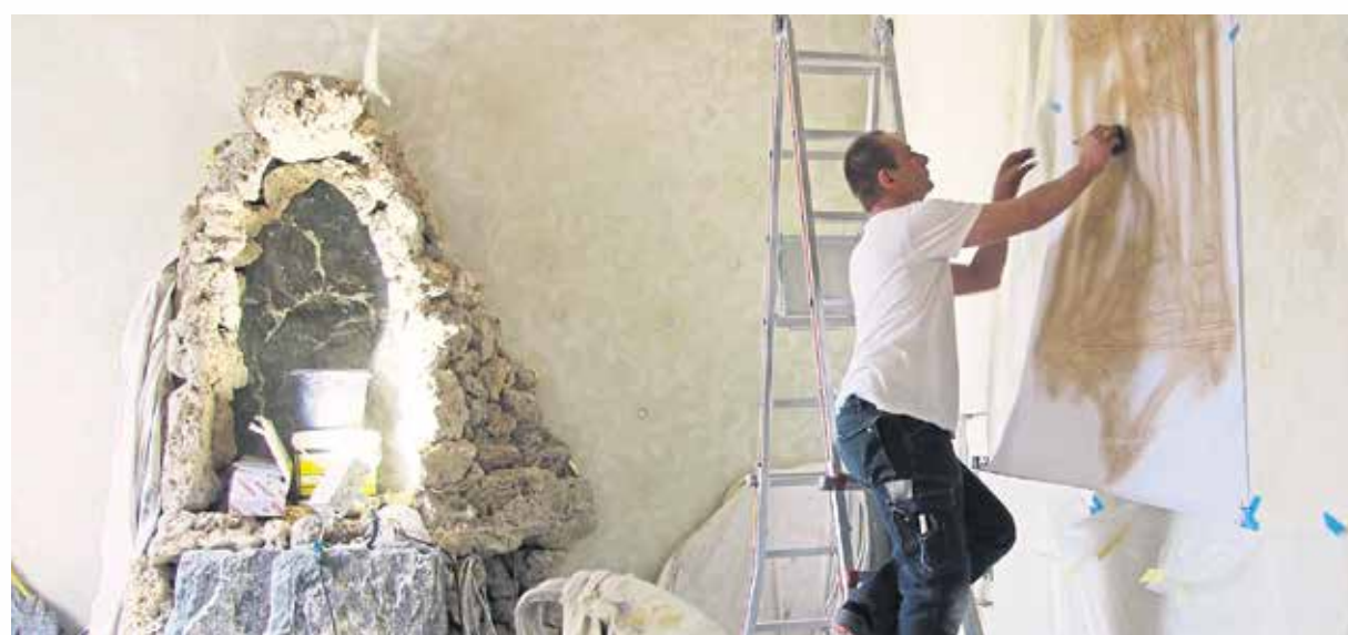
Noch Baustelle: Kirchenmalermeister Kai Berger restaurierte gemeinsam mit einem Kollegen die Grottenkapelle in Grafenhausen.
