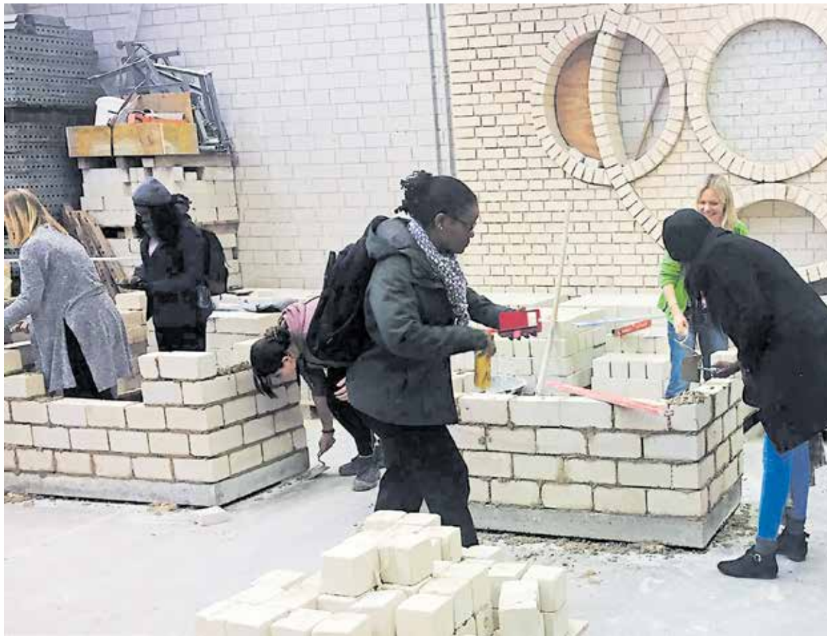
Spannende Einblicke festgehalten: Die Gruppe der University of Namibia nahm in der Bauwerkstatt auch selbst die Kelle in die Hand. Foto: HWK FR
