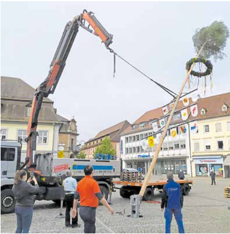
Der Maibaum auf dem Emmendinger Marktplatz wurde in diesem Jahr mit Hilfe eines Krans aufgestellt. Foto: KHS Emmendingen
